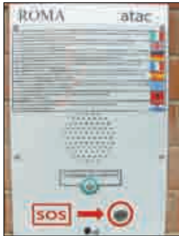
A sinistra, il pannello per le chiamate di emergenza. Sopra, la colonnina Sos installata alla stazione Ponte Mammolo della metro B.
