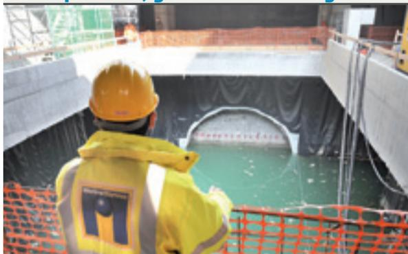
Sopralluogo ieri nello scavo della metropolitana della galleria Dante. I lavori sono fermi da oltre un mese a causa di un allagamento per l’innalzamento della falda. È stata fatta un’ispezione subacquea per permettere di misurare lo spessore di paratia ancora da rimuovere per liberare la talpa. **R.A.**
