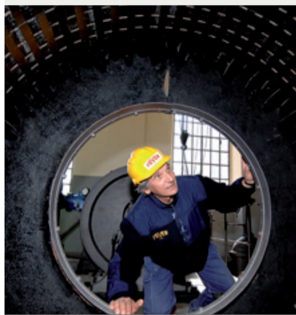
È stata inaugurata ieri a Brindisi la prima centrale idroelettrica in Puglia, impianto in grado di produrre energia elettrica pulita per un cittadina di 30 mila abitanti. METRO
