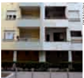
Le case popolari di via Uccelli di Nemi in ristrutturazione.
