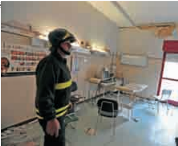
Le verifiche dei vigili del fuoco all'interno dell'ospedale.
