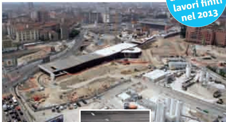
Una veduta del cantiere di Porta Nuova. Al centro, il tunnel.
