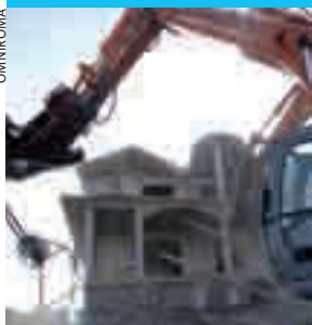
La villa demolita.
