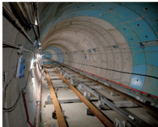
I lavori in galleria (Foto archivio Gtt)
