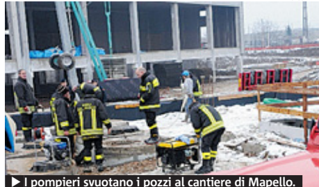
► I pompieri svuotano i pozzi al cantiere di Mapello.
