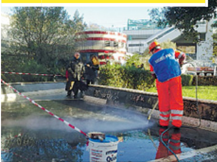
► L'intervento dell'Ama alla stazione Valle Aurelia. METRO
