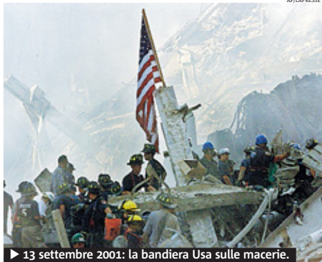
► 13 settembre 2001: la bandiera Usa sulle macerie.
