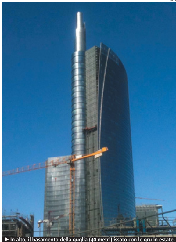
► In alto, il basamento della guglia (40 metri) issato con le gru in estate.
