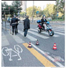
► Il cantiere oscura le strisce di via Manin.
