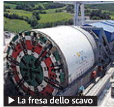
► La fresa dello scavo. METRO
