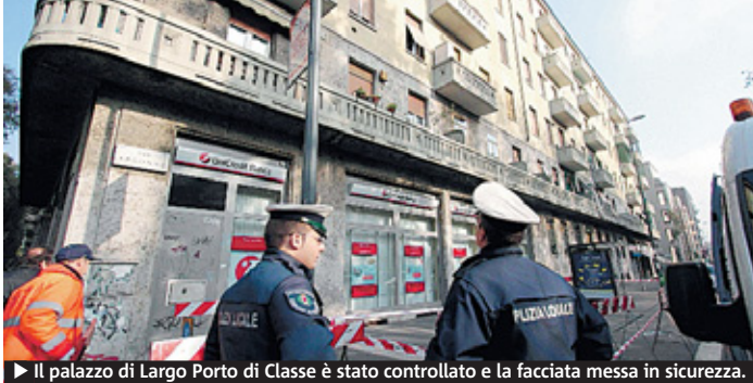
► Il palazzo di Largo Porto di Classe è stato controllato e la facciata messa in sicurezza.
