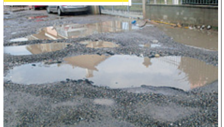
▶ Il degrado della via dopo le piogge dei giorni scorsi.
