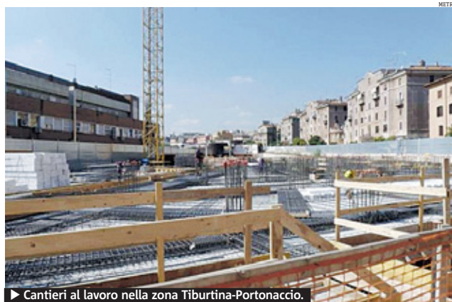
► Cantieri al lavoro nella zona Tiburtina-Portonaccio.
