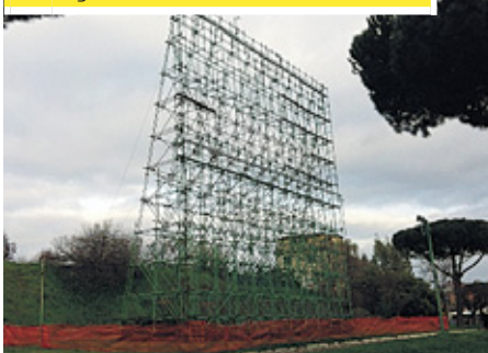
► Tolate tutte le lastre della maxi struttura abusiva in piazzale del Lavoro.
