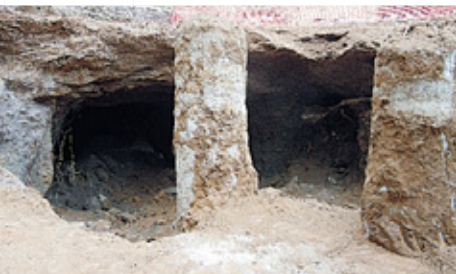
► Gli ingressi delle gallerie messe a nudo dal cantiere. METRO
