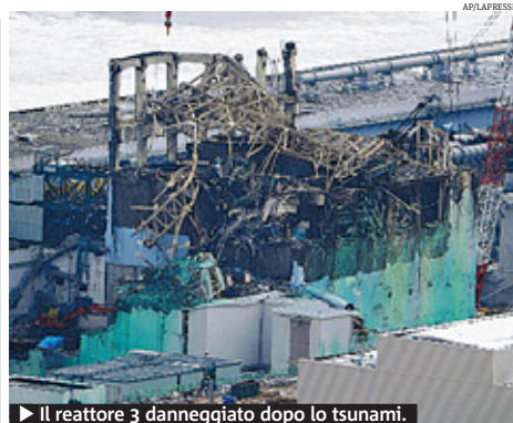
► Il reattore 3 danneggiato dopo lo tsunami.
