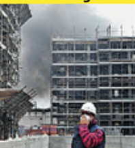
► La colonna di fumo nel cantiere edile.
