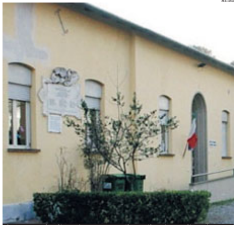
► La scuola di Rosignano con il cortile pieno di amianto.
