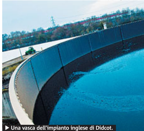
► Una vasca dell'impianto inglese di Didcot.
