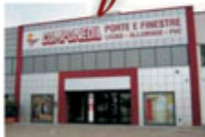
VITTUONE (MI) Strada Statale Undici N°28
