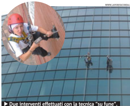
► Due interventi effettuati con la tecnica "su fune".
