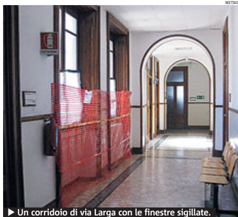
► Un corridoio di via Larga con le finestre sigillate.
