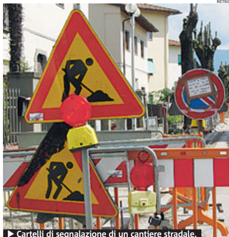
► Cartelli di segnalazione di un cantiere stradale.
