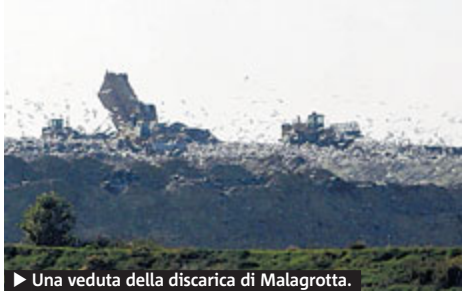
► Una veduta della discarica di Malagrotta.
