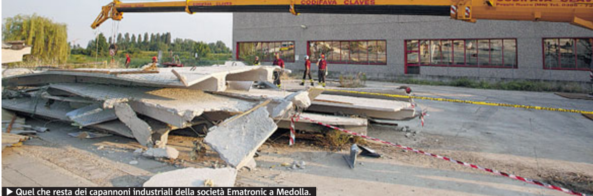
► Quel che resta dei capannoni industriali della società Ematronic a Medolla.
