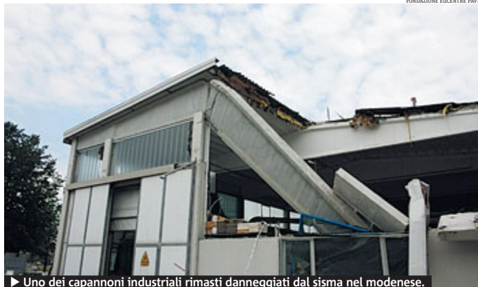
► Uno dei capannoni industriali rimasti danneggiati dal sisma nel modenese.
