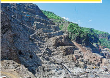
► Il cantiere della diga nella Valle di Omo, in Etiopia. AFP
