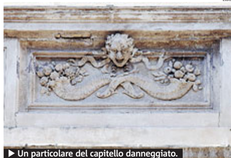
▶ Un particolare del capitello danneggiato.
