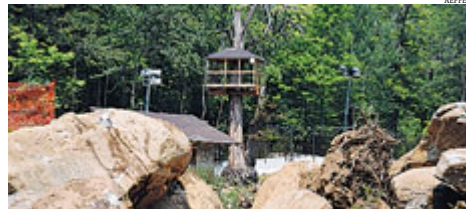
► Il cantiere con una delle case sull'albero, costruite in passato dai No-Tav e ora inglobate nell'area di lavoro.
