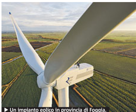
► Un impianto eolico in provincia di Foggia.
