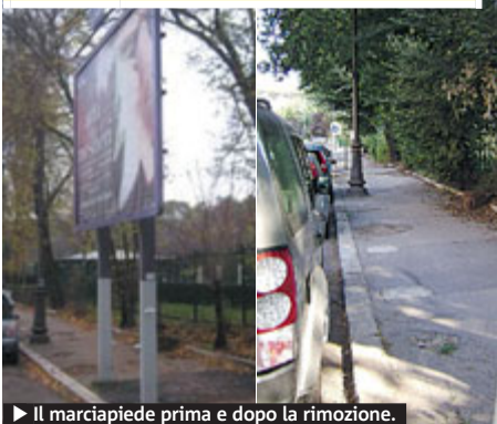
► Il marciapiede prima e dopo la rimozione.
