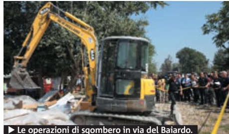
► Le operazioni di sgombero in via del Baiardo.
