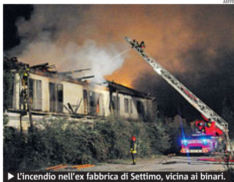
L'incendio nell'ex fabbrica di Settimo, vicina ai binari.
