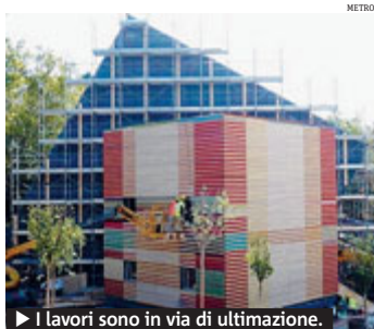
► I lavori sono in via di ultimazione.
