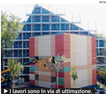
► I lavori sono in via di ultimazione.
