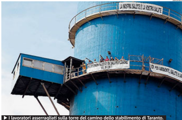
► I lavoratori asserragliati sulla torre del camino dello stabilimento di Taranto.
