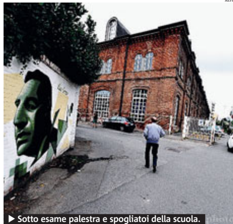
► Sotto esame palestra e spogliatoi della scuola.
