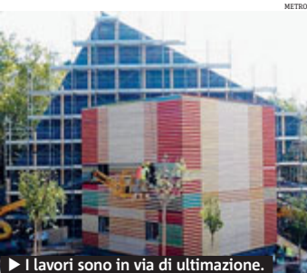
► I lavori sono in via di ultimazione.
