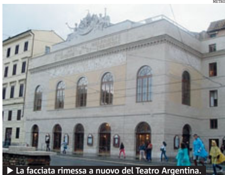
► La facciata rimessa a nuovo del Teatro Argentina.
