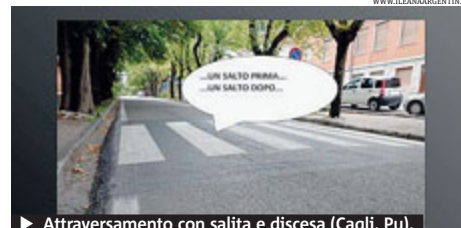
► Attraversamento con salita e discesa (Cagli, Pu).
