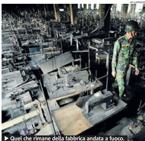
► Quel che rimane della fabbrica andata a fuoco.
