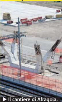
► Il cantiere di Afragola.
