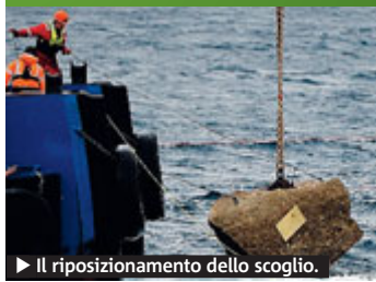
► Il riposizionamento dello scoglio.
