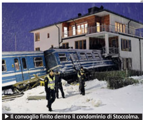
► Il convoglio finito dentro il condominio di Stoccolma.
