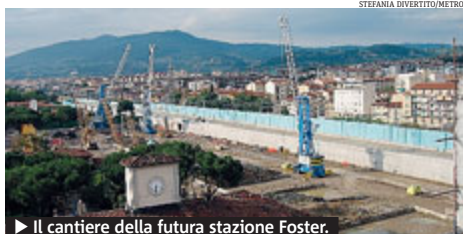
► Il cantiere della futura stazione Foster.
