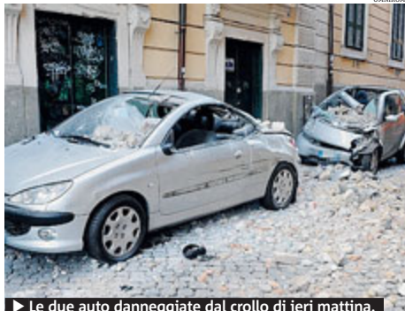
► Le due auto danneggiate dal crollo di ieri mattina.
