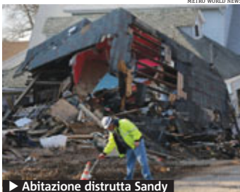
▶ Abitazione distrutta Sandy
