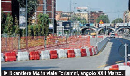
► Il cantiere M4 in viale Forlanini, angolo XXII Marzo.
