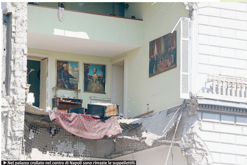
► Nel palazzo crollato nel centro di Napoli sono rimaste le suppellettili.
