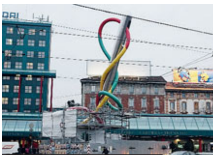
► L'opera quasi libera dalle impalcature.
