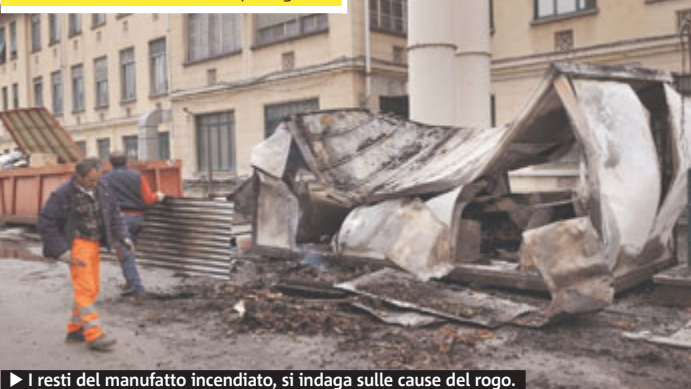
▶ I resti del manufatto incendiato, si indaga sulle cause del rogo.
