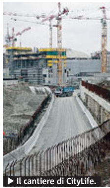
Il cantiere di CityLife.
