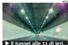
► Il tunnel alle 11 di ieri.
