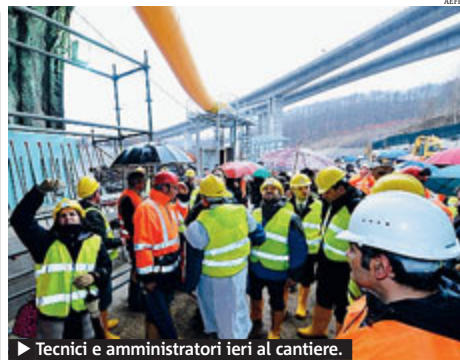
► Tecnici e amministratori ieri al cantiere.
